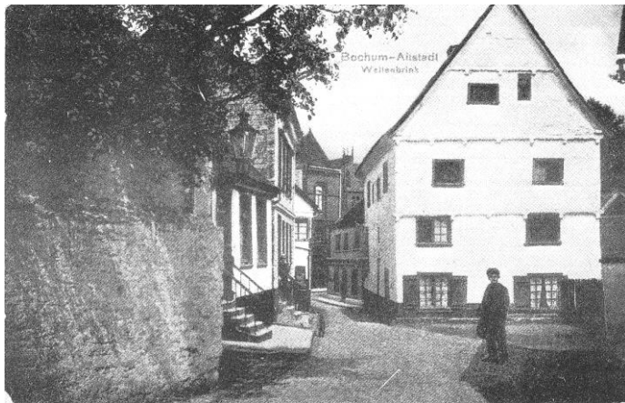
„Bis zur Zerstörung im II. Weltkrieg galt der Weilenbrink im Herzen des Stadtkerns als schönste Alt-Bochumer Straße mit den Fachwerkhäusern und dem stillen, lindenbestandenen Platz vor der Reformierten Kirche, der ‚Pfefferdose‘, von 1698.“ (Johannes Volker Wagner: Bochumer Ansichten auf alten Postkarten, Bochum 1979, S. 19)
