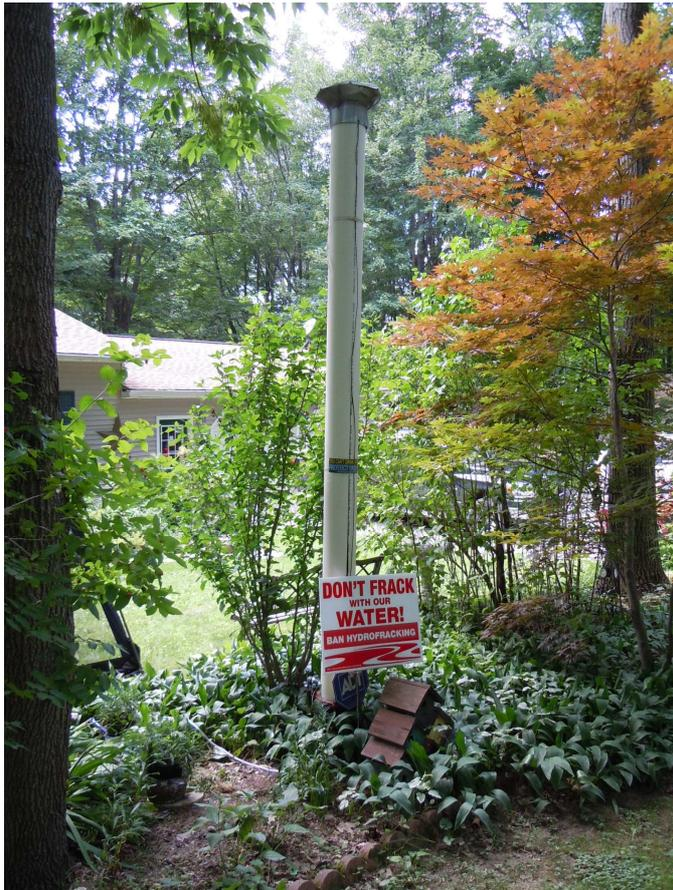
Abb. 4: Unkontrollierter Gasaustritt in einem Hausbrunnen (mit Entlüftungsrohr) in Pennsylvania
