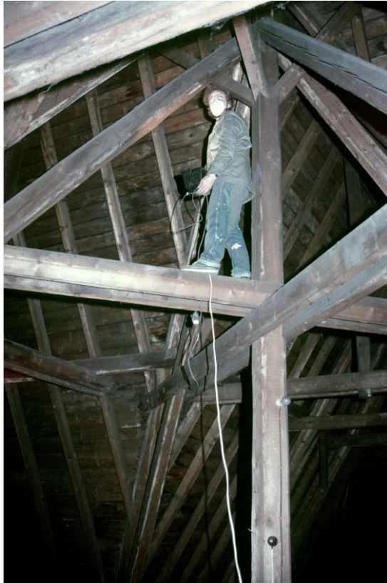
Auf dem Dach der Lukaskirche (Wittener Straße)
